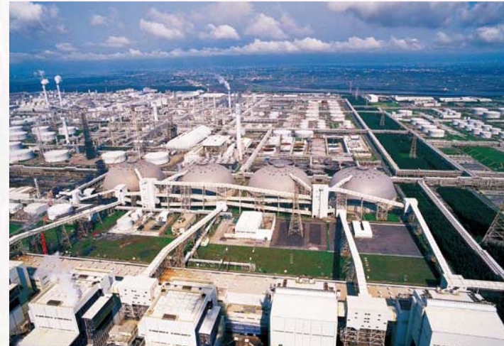
▲本企業廠區皆已設置自動化密閉式煤倉，以杜絕煤塵飛揚，確保空氣清淨
